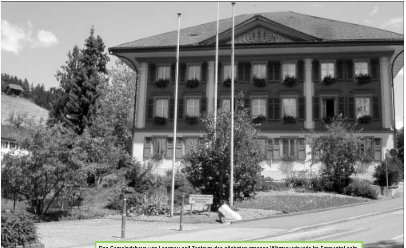
Das Gemeindehaus von Langnau soll Zentrum des nächsten grossen Wärmeverbands im Emmental sein.
