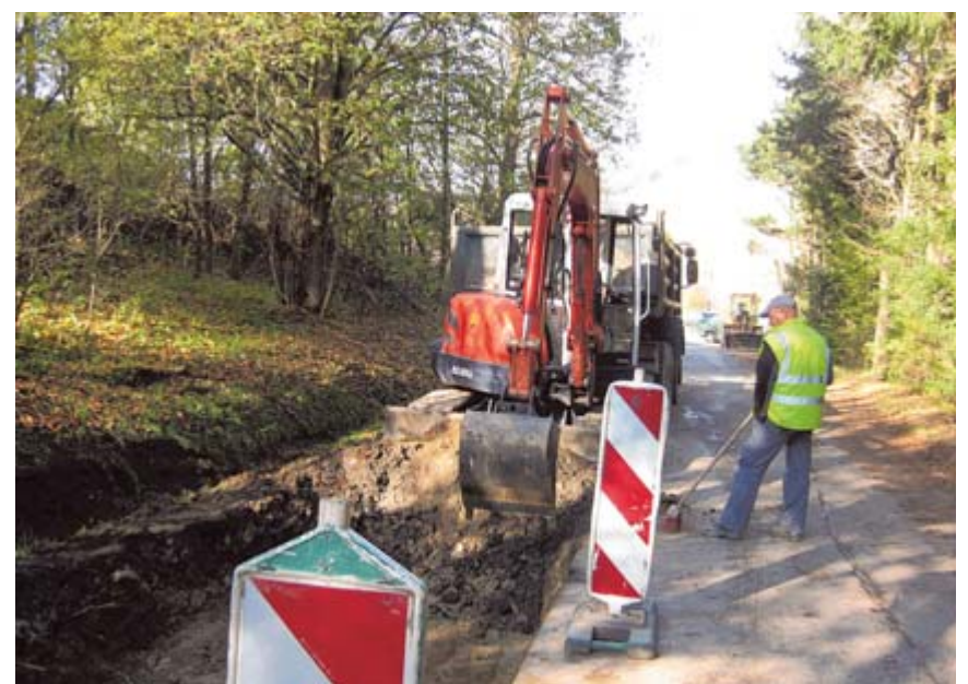
Die Arbeiter der Straßenbaufirma Spreng nehmen Fahrbahnreparaturen im Pommernweg, der Zugangsstraße zu den Friedhofseingängen, vor. BILD: BALTZER
