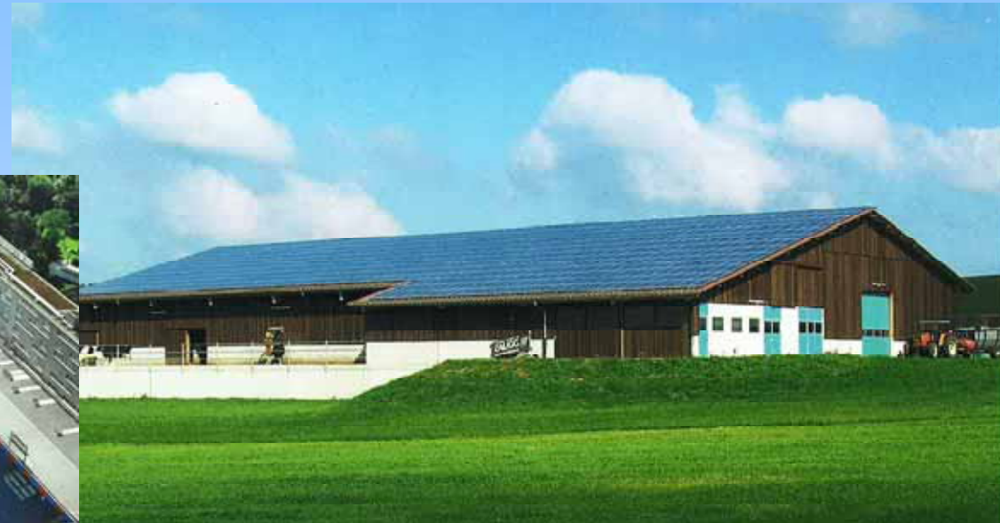
113 kW Solaranlage Bachsäge Diegten ca. 90'000 kWh / a
