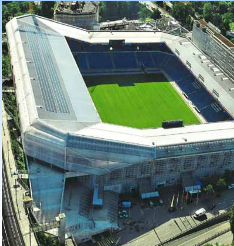
202 kW Solaranlage St. Jakob ca. 170'000 kWh / a
